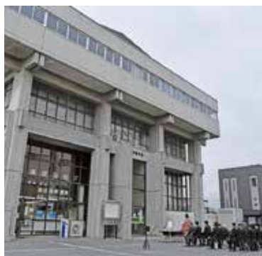
▲旧本所建物解体に向け清拭い を行う関係者ら
